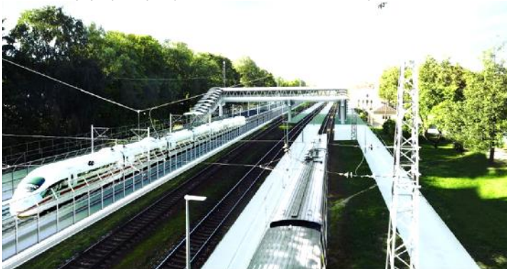
40.att. Gājēju pārejas piemērs (Zasulauka stacija)
